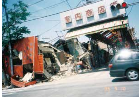
阪神淡路大震災（神戸市長田区）被災から4か月後、二度目の現地入り
